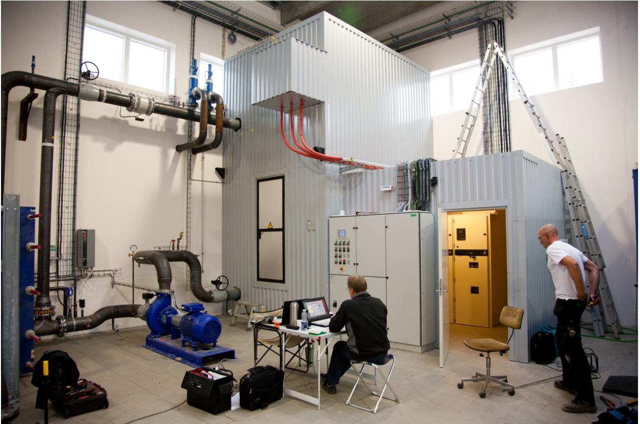
Mens den nye tilkobling mellem fliskedel og skorsten står på, sikres varmforsyningen af elkedlen, som er etableret i den nye tilbygning mod vest.
